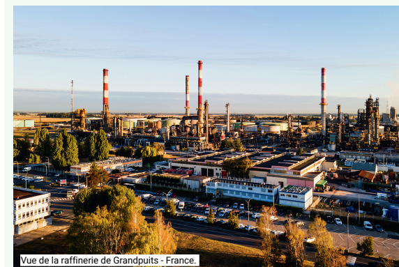
Vue de la raffinerie de Grandpuits - France.
