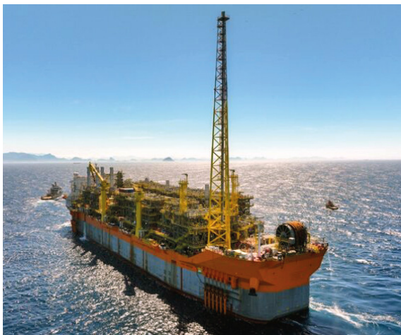
FPSO Sepetiba, Brésil
