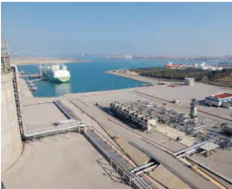
LNG Altamira's re-gasification terminal.
