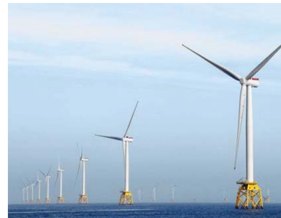
Éoliennes offshore en mer du Nord.
