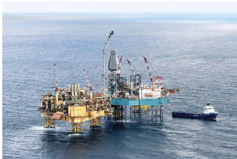
La plateforme d'Elgin Franklin en mer du Nord.
