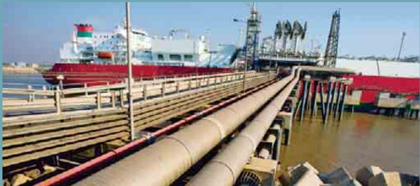
LNG Hazira's re-gasification terminal.
